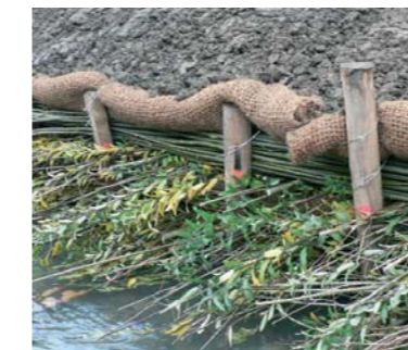
Albanne. L'abri sous-berge terminé, avant végétalisation du talus.
