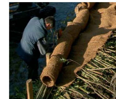
Albanne. Mise en place de branches de saules, recouvertes par le boudin de géotextiles en toile de coco.
