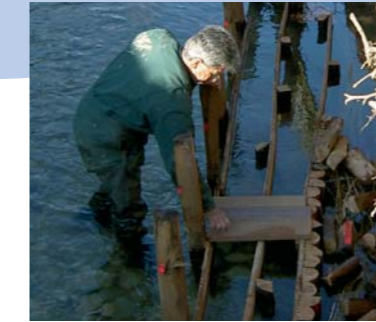
Albanne. Création d'un abri sous-berge. Mise en place de planches entre les rangées de pieux.
