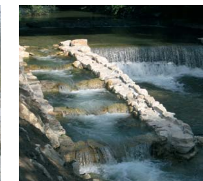
Sierroz. Passe à poissons constituée de 4 bassins en enrochements liaisonnés.
