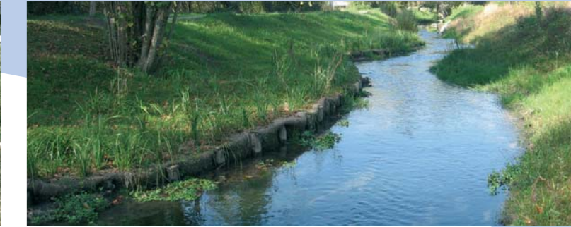
Deysse. Nouveau lit méandriforme avec fascine d'hélophytes en risberme.
