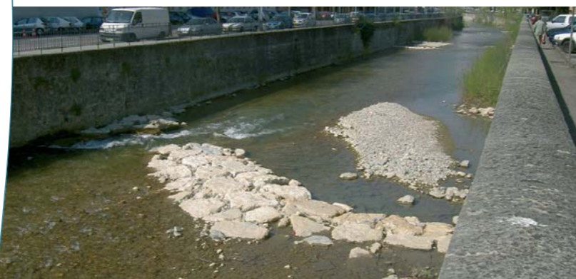
Leysse. Seuil de fond avec échancrure latérale. Outre la stabilisation du profil en long, l'ouvrage permet de diversifier les écoulements en amont (radier/mouille) et en aval (fosse).
