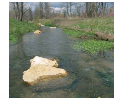
Deysse. Amas de blocs dans le lit d'étiage pour diversifier les écoulements. On note au 2 nd plan la végétation en contact avec l'eau.
